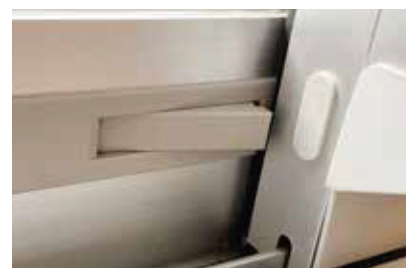
バルコニー窓に補助錠設置
